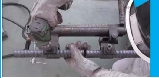
鉄筋支持器で鉄筋を固定
