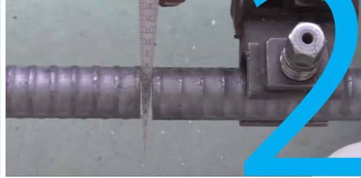
ゲージで開先幅を確認
